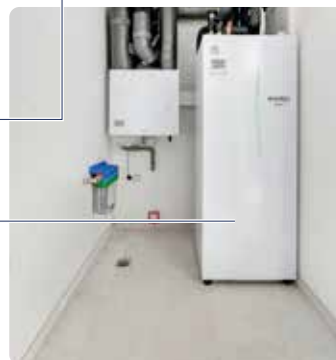
Ecodan Cylinder, vodna enota toplotne črpalke z integriranim rezervoarjem sanitarne vode.
